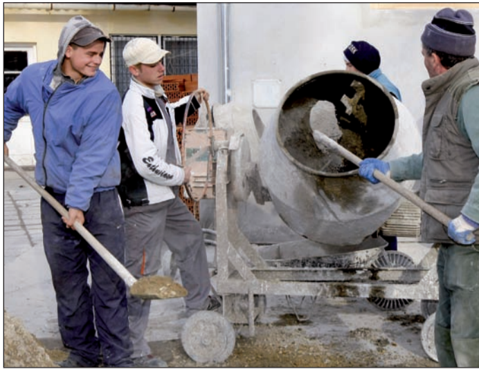
A betonkeverővel ismerkednek a tanulók
