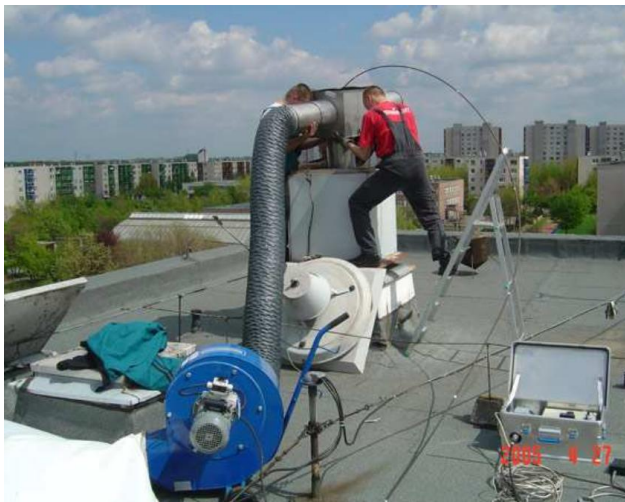
26. ábra 59 Nagyteljesítményű porszívó üzemeltetése, függőleges szellőzőjárat tisztításakor.
