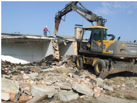
24. ábra Épület bontása 15
