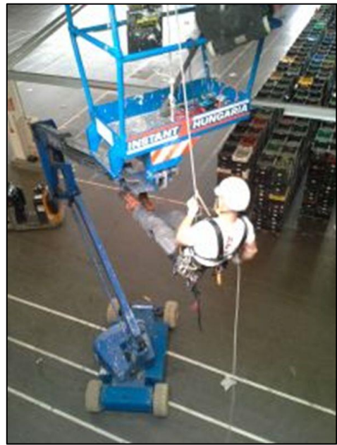
7. ábra Emelőgépből önmentés (készítette a szerző, 2013.)
