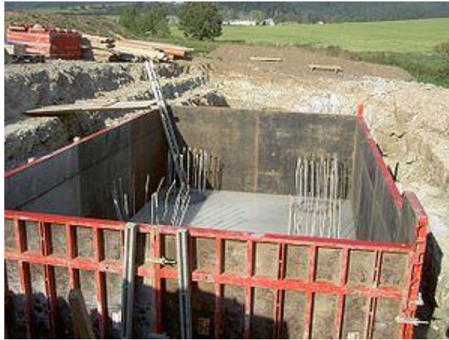
Alapozáshoz használt, moduláris acélszerkezetű zsaluzat
