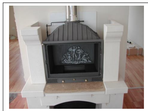
5.13 ábra: Felállított oldalelemek
