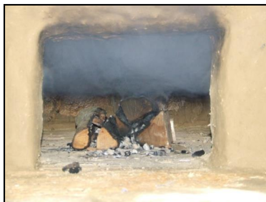
5.37 ábra: Kemence tüzelőnyílásán alul megy be az égéslevegő, fölül jön ki a füst
