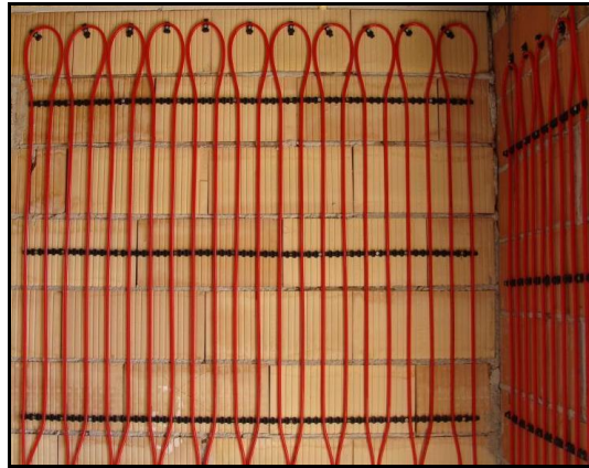
5.44 ábra: Hőhasznosító csőkígyó
