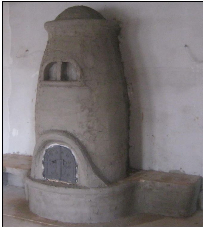
5.31 ábra: Fűtőkemence, vakolás közbeni állapot
