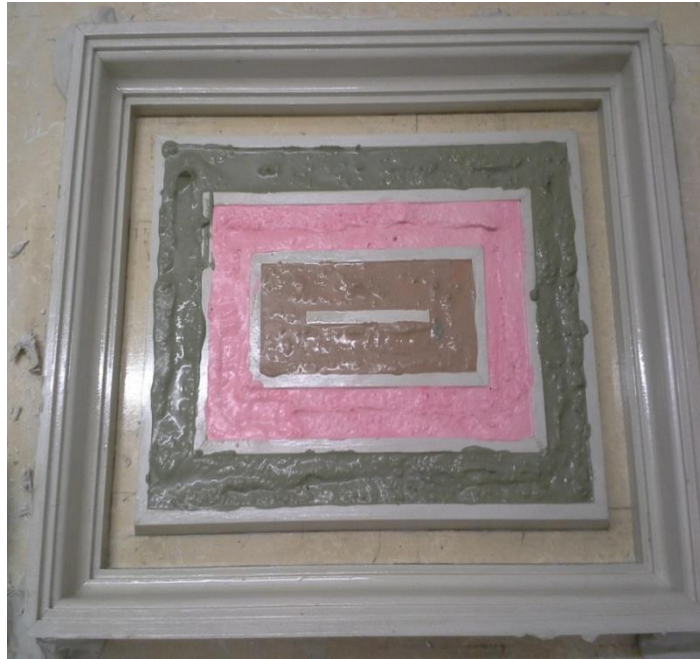
56.ábra terrazzo beöntési folyamata
