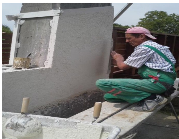
49.ábra felhordás és szintezés, simítás acélsimítóval
