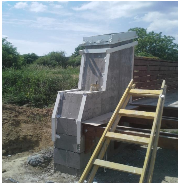
48.ábra a rézsútos gipszlécek felszerelése az élek mentén
