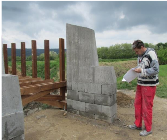
47.ábra helyszíni műkövés alapfelülete, mérték ellenőrzése a rajz alapján
