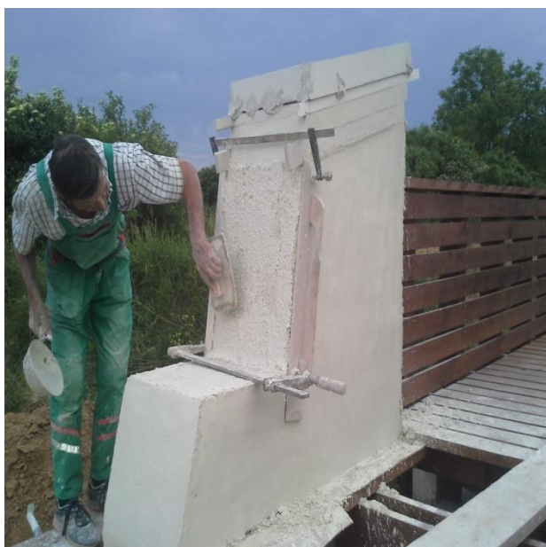
50.ábra a felhordott műkő besimítása fasimítóval
