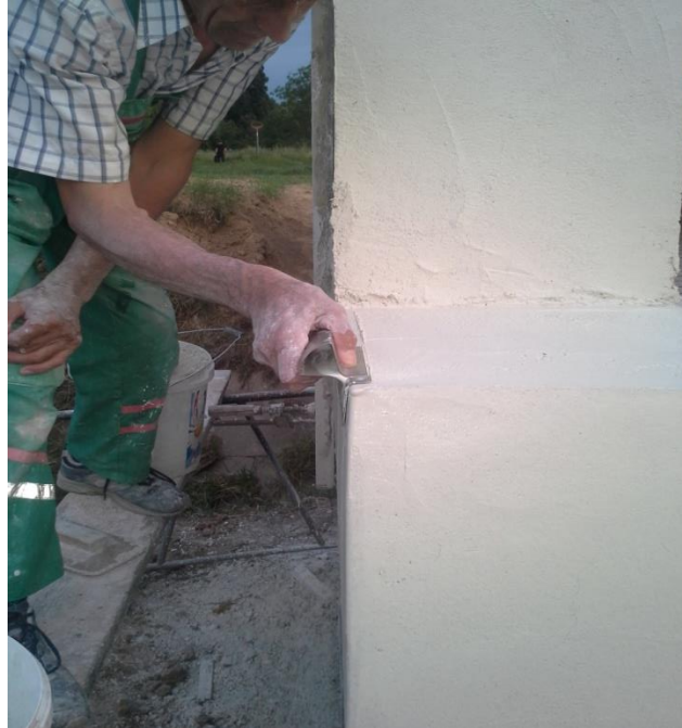
51.ábra él simítás él simítóval
