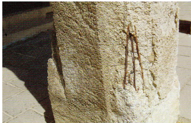
19.ábra a használt csapolás helytelen megvalósítása
