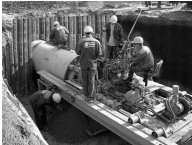
5. ábra Sajtoló indulóakna képe 5
