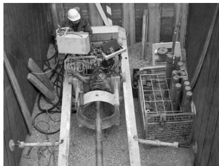
3. ábra Acélcső átsajtolás 3
