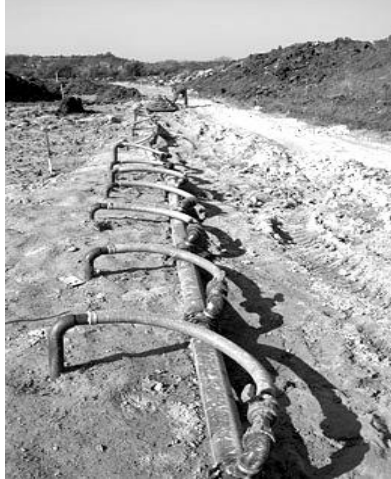
2.ábra Vákuumos talajvízszint süllyesztés 2
