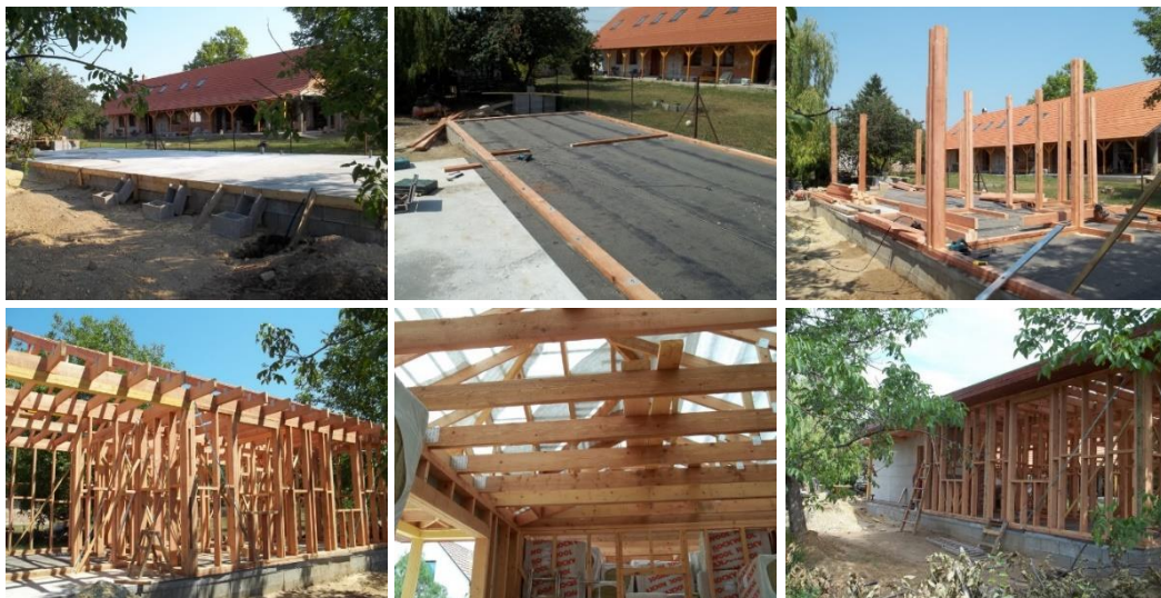
9. ábra Favázás épület építése 9
