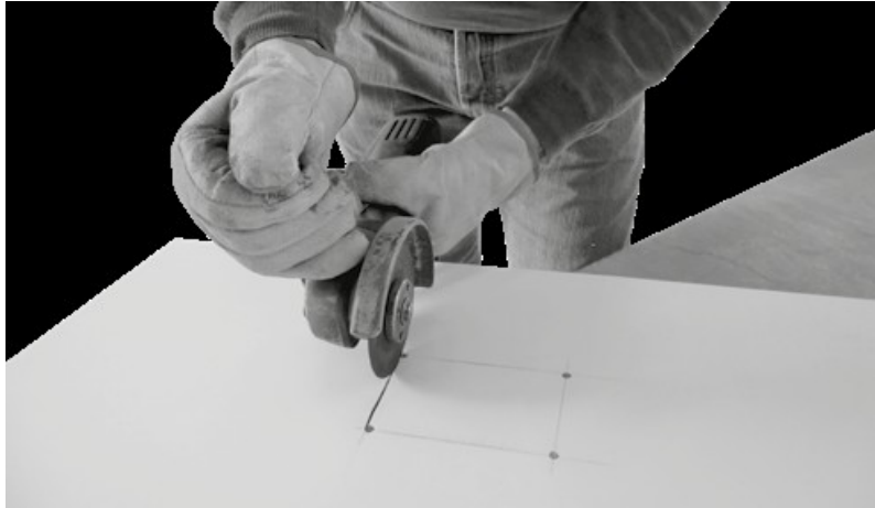
34. ábra Belső vágás készítése
