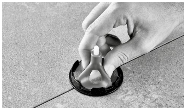
36. ábra Mechanikus szintező
