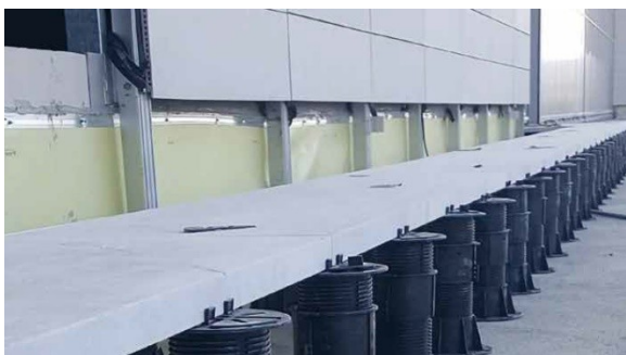
26. ábra Képzett álpadló rendszer I.
