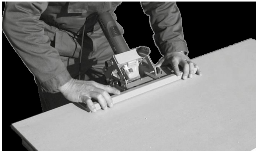
35. ábra Élek kidolgozása speciális kocsi használatával
