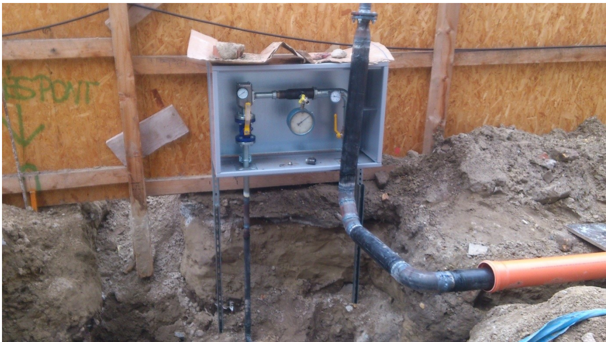
25. számú ábra a helyszínen elhelyezett nyomáspróba felszerelés
