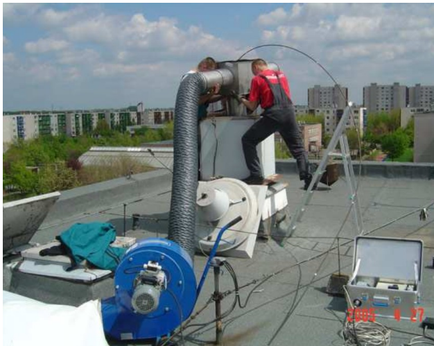
32. ábra 56 Nagyteljesítményű porszívó üzemeltetése, függőleges szellőzőjárat tisztításakor.
