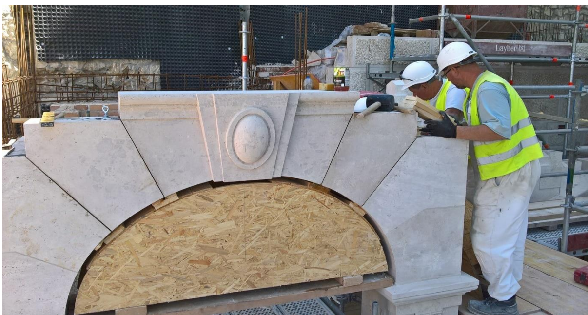
41. ábra Kőelemek elhelyezése mintaszaluzaton
