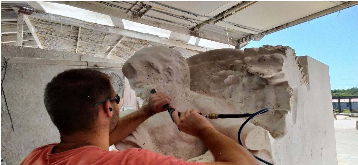
25.ábra pontozógéppel átmásolt pozíció finomítása
