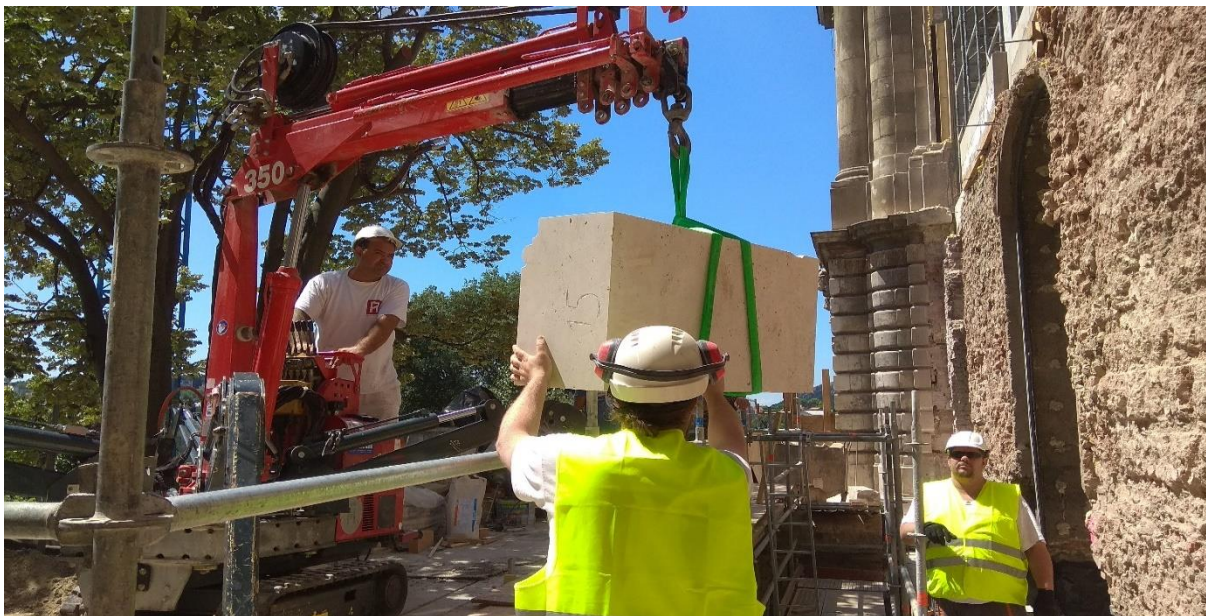
40.ábra gépi kőmozgatás a beépítés helyszínére
