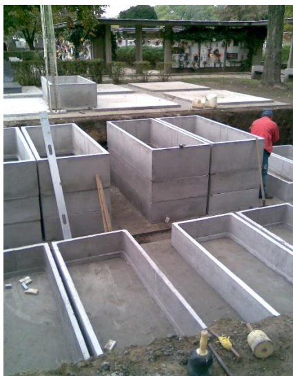
62.ábra kripta előregyártott elemi 62.ábra kripta felszín feletti megjelenítése
