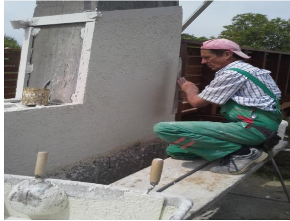
47. ábra felhordás és simítás acélsimítóval
