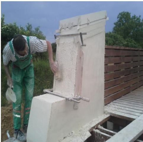
48.ábra a felhordott műkő besimítása fasimítóval
