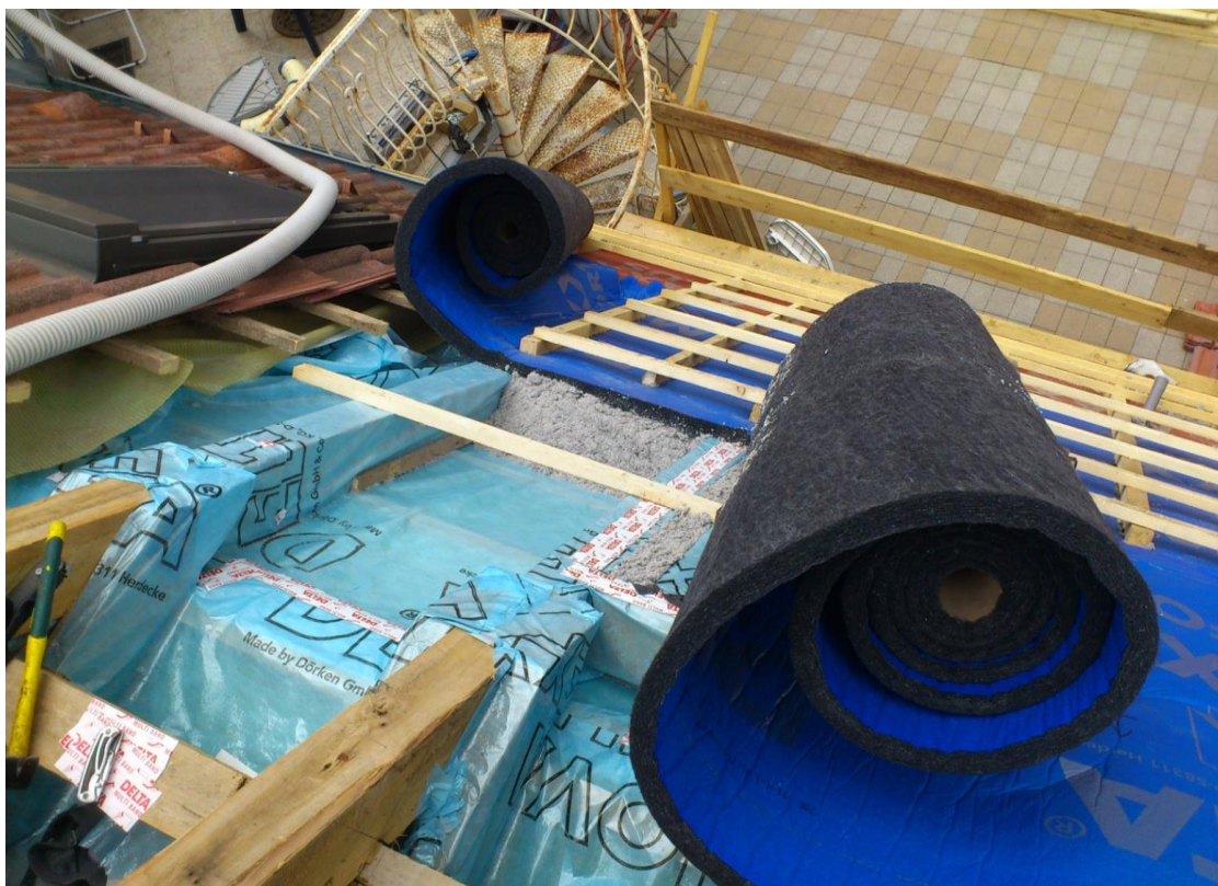
Tető felújítás kívülről Dörken termékcsaláddal és környezet barát Thermoflock fújható hőszigeteléssel
