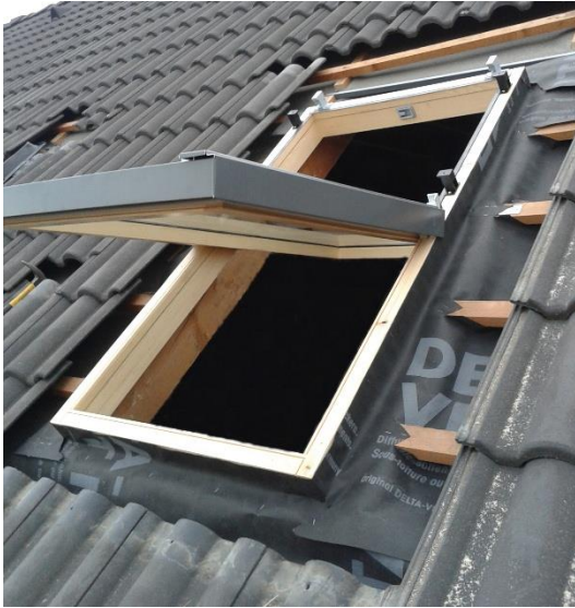
27. ábra: A betétfólia szakszerű elhelyezése
