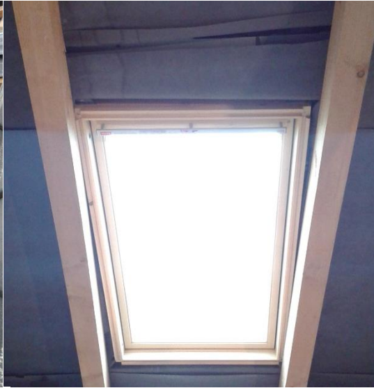
28. ábra: A fólia megszakítása, kondenzvíz elvezető behelyezése
