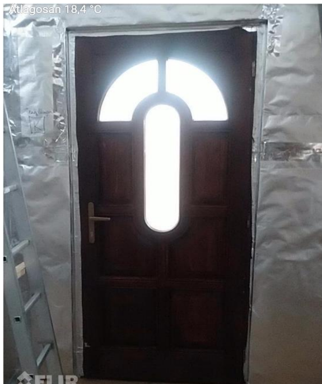
Könnyűszerkezetes ház jól beépített bejárati ajtaja
