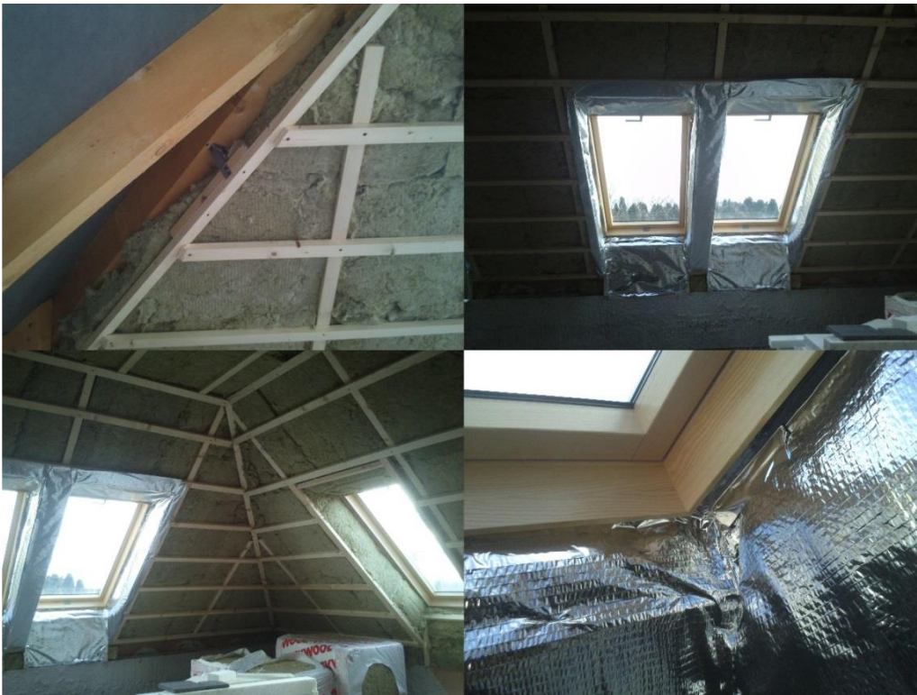
32. ábra: A tetősík szigetelés, és az ablakok belsőfólia kialakítása
