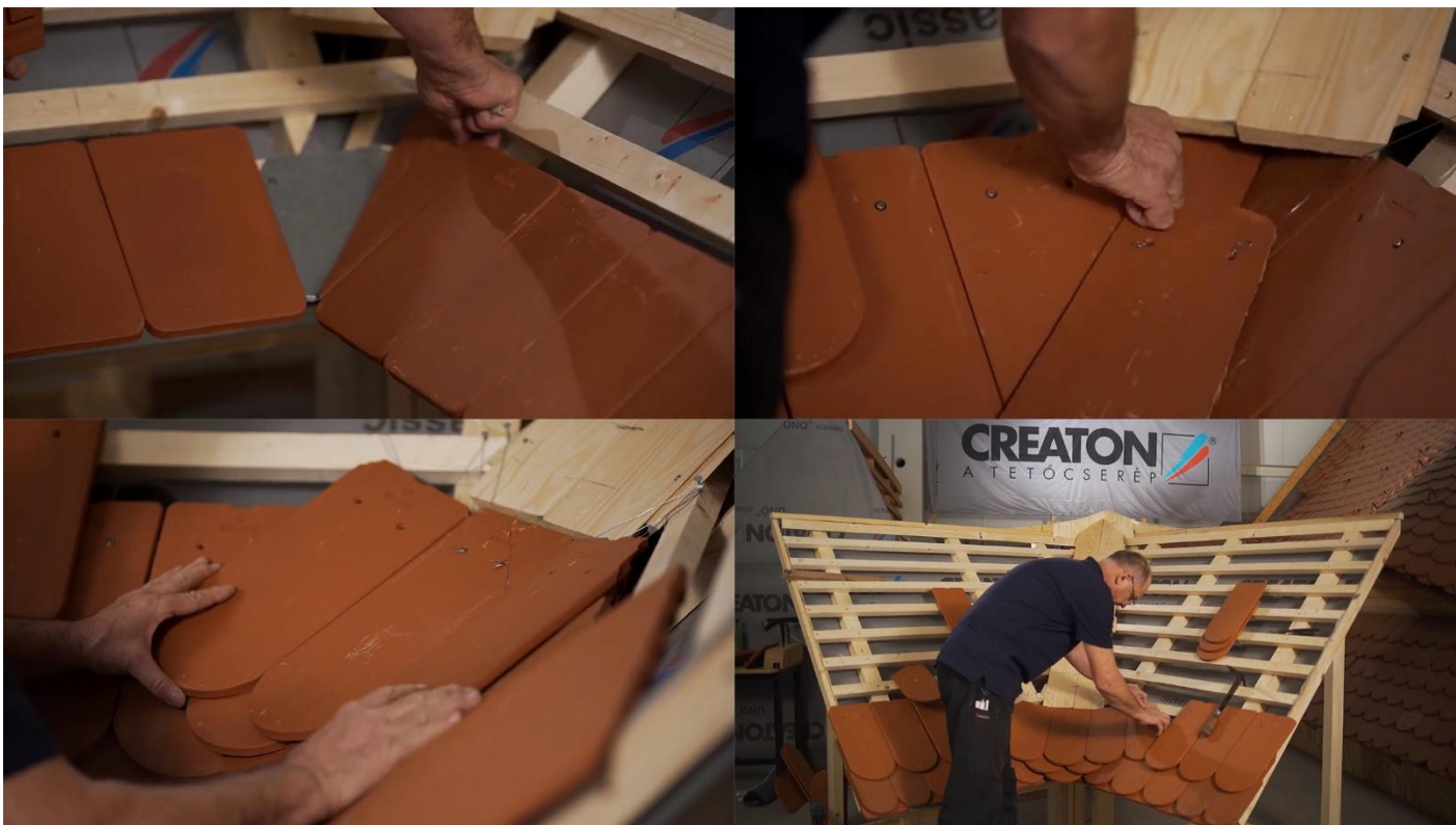
Két cserép széles német vápa készítése kettősfedés esetében.
