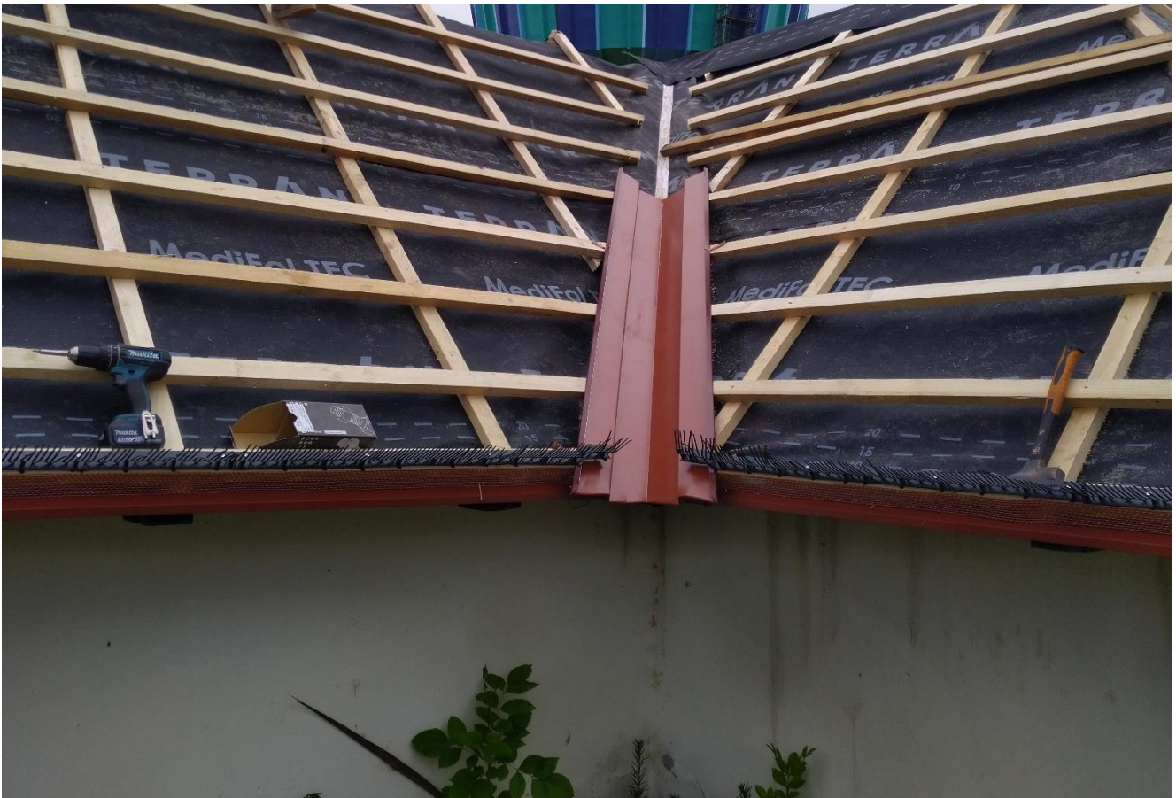
süllyesztett vápa kialakítása
