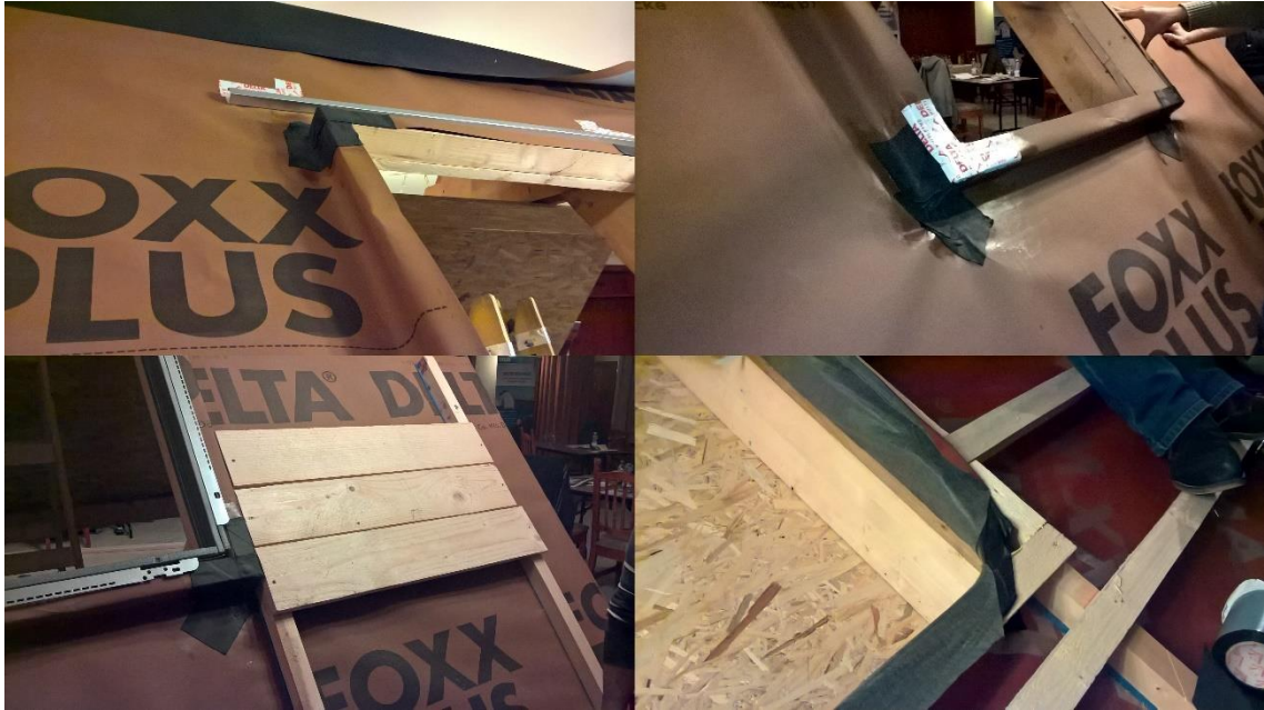
a külső tetőfólia helyes kiragasztása pl: egy tetőablak sarkainak az áttörésében
