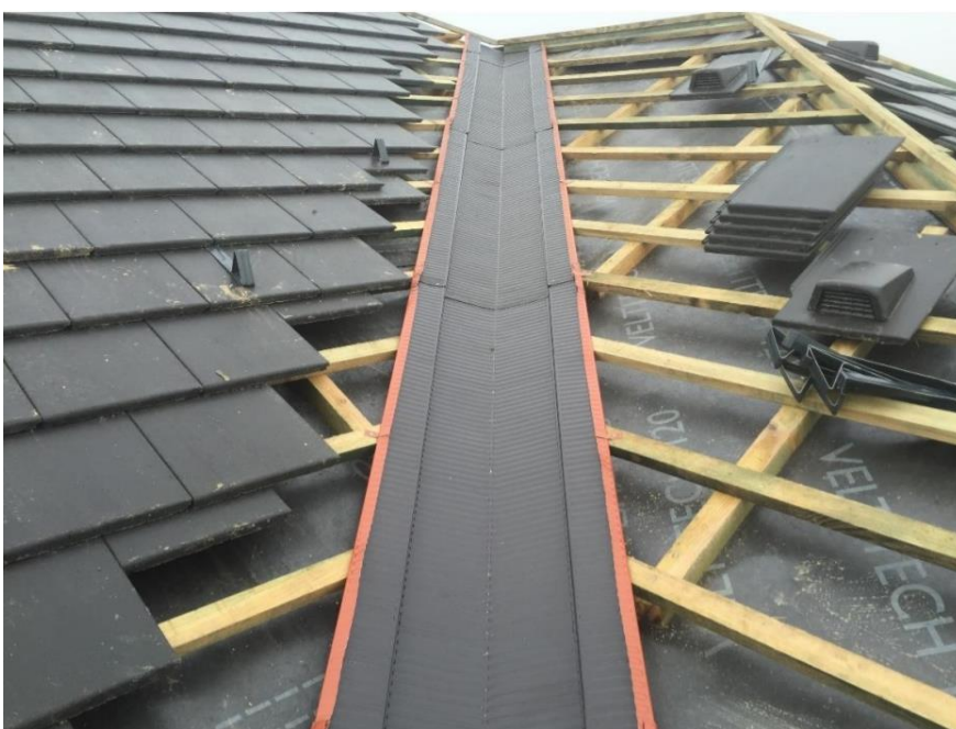
süllyesztett vápa kialakítása
