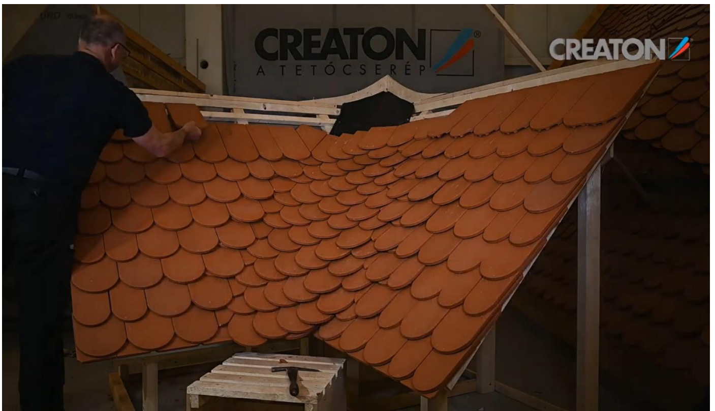
Az egyoldalról átevezetett vápa fedési képe kettős fedés esetében
