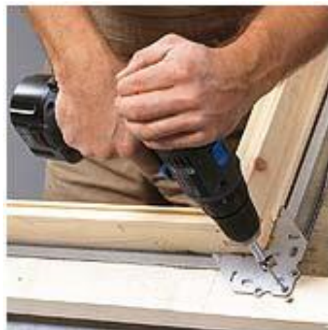
26. ábra: A tok rögzítése (forrás: www.velux.hu )
