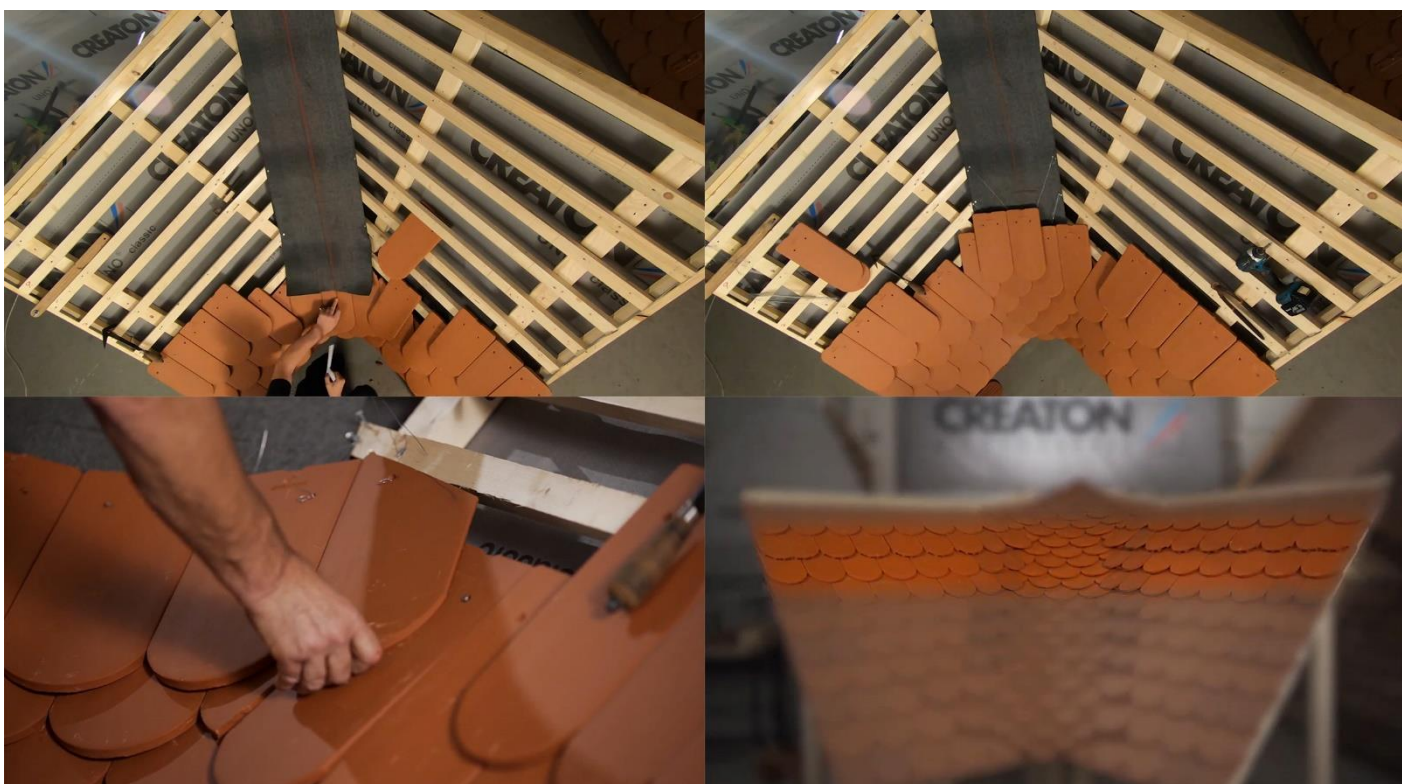
Két cserép széles német vápa készítése kettősfedés esetében.
