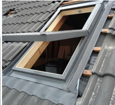
30. ábra: Körbeburkolás bádogmezzel
