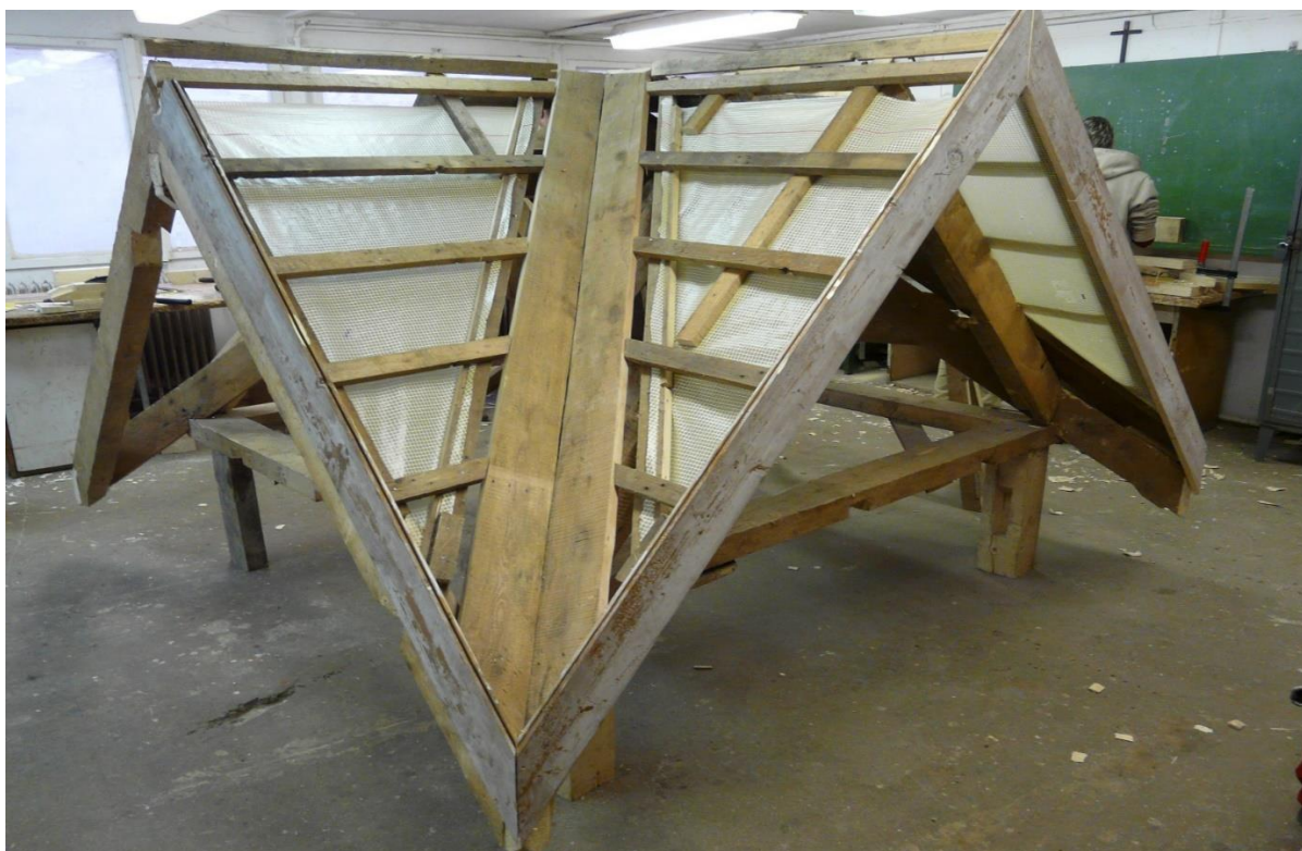
A régi iskola vápa kiszellőztetése és alátét héjazat kialakítása
