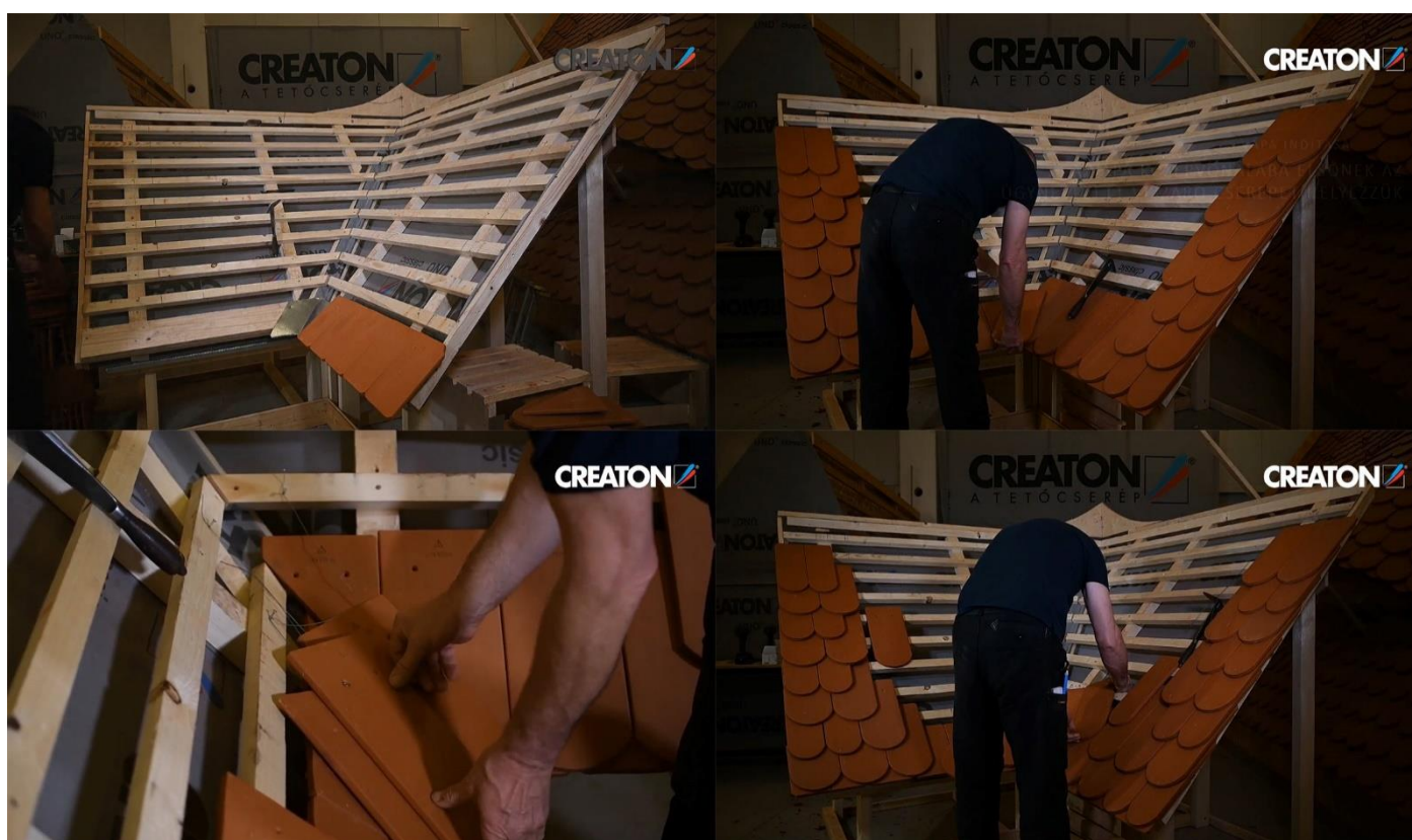
Az egyoldalról átvezetett vápa készítése kettős fedés esetében
