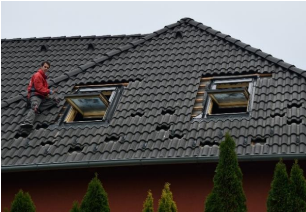
29. ábra: A cserepek visszarakása és beszabása
