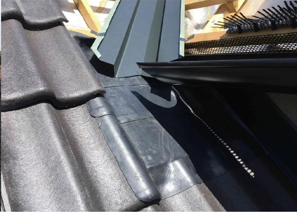
süllyesztett csonka vápa kialakítása Wakaflex-el
