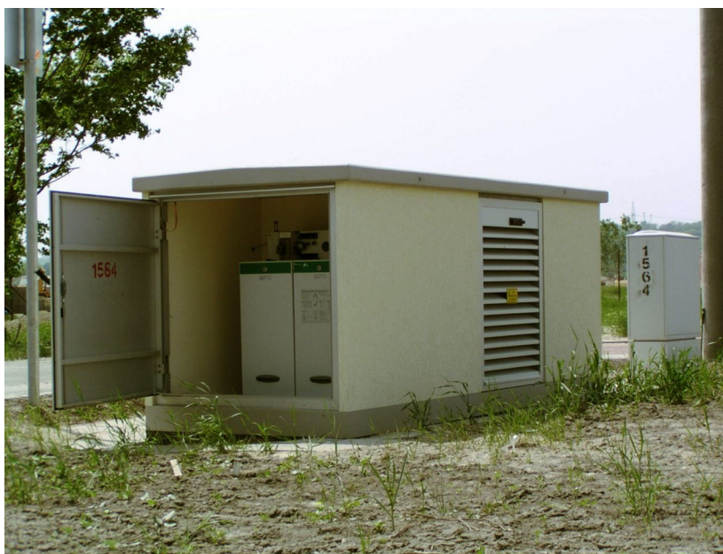
4.7 ábra Előszertelt transzformátorállomás (Enertech)
